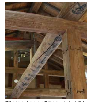
昭和30年に上棟した古民家からいただいた極太の梁が宿を守る安心感。
